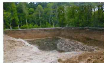
土石の掘削状況（イメージ）
