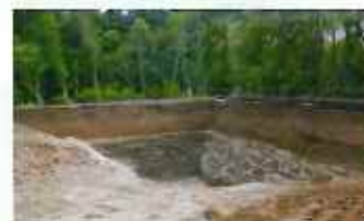
土石の掘削状況（イメージ）
