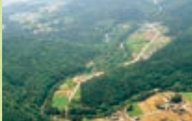
4 緑のトラスト保全第4号地 飯能河原周辺河岸緑地 (飯能市 2.3ha)
