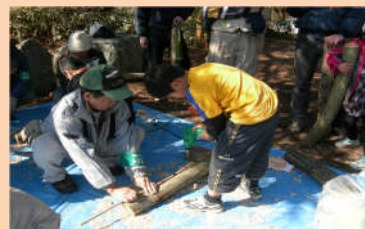
ドリルで穴開け
